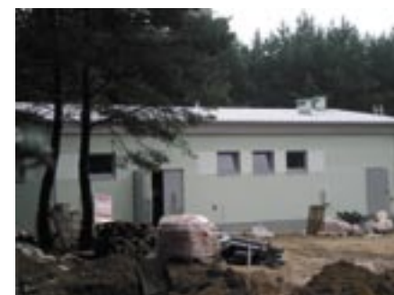
Nowy budynek stacji uzdatniania wody w Wierzbicy
