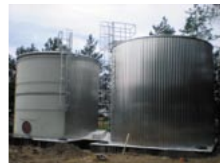
Nowe zbiorniki na wodę czystą na stacji uzdatniania wody w Wierzbicy.
