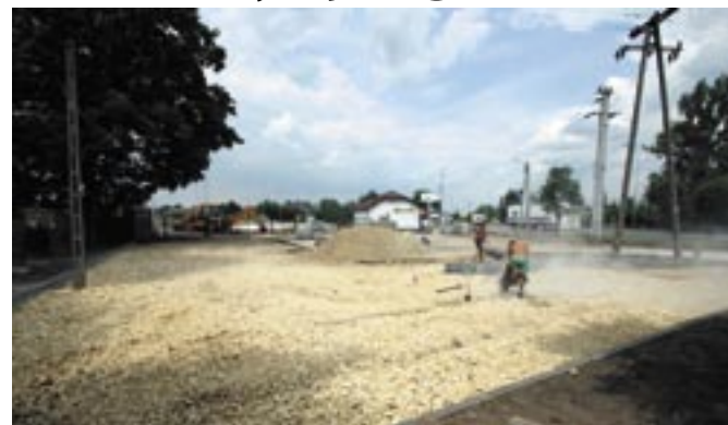
Budowa parkingu przy stadionie miejskim w Serocku
