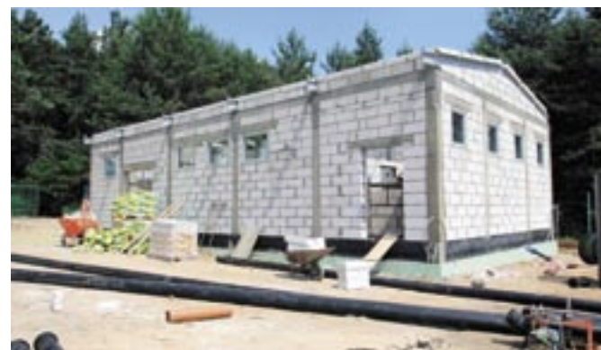
Budowa budynku stacji uzdatniania wody w Wierzbicy
